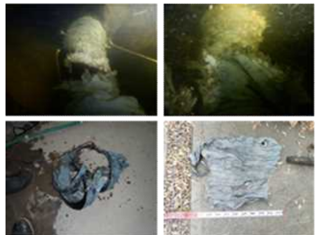
図-6 羽根車に噛込んだビニルシート片
