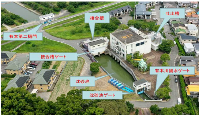
図-1 有本揚排水機場の所在地及び外観
