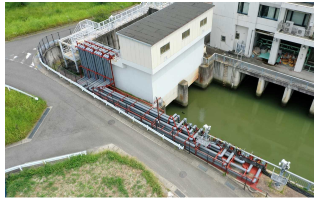
図-10 仮設ポンプ設置完成図
