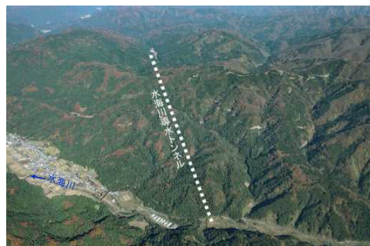
写真-1 水海川導水トンネル全景(トンネル呑口側より撮影)
