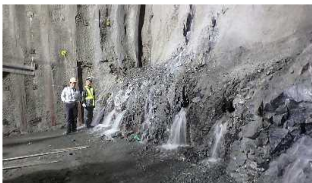
写真-2 TD1,850m 地点の集中湧水状況
