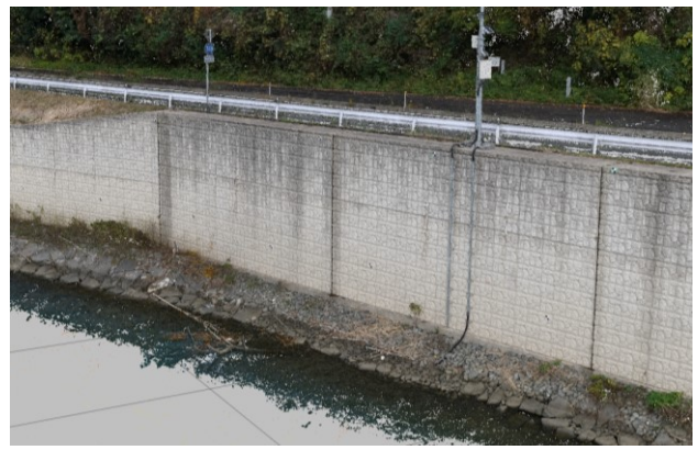
図-7 UAVで計測した点群データ (地上データ)
