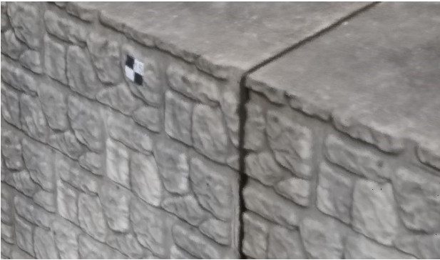
図-9 直壁の点群データ (拡大)
