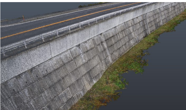
図-11 UAV計測した点群データ
