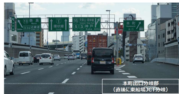
図-2 予告標識と分岐部標識の併設による煩雑な分岐案内（本町出口分岐部付近）
