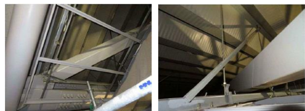
図-3 既存天井内の様子
