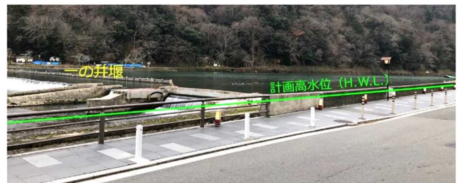
図1-2 渡月橋上流左岸の状況
