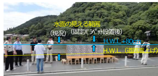
図5-3 模型を用いた景観への影響確認
