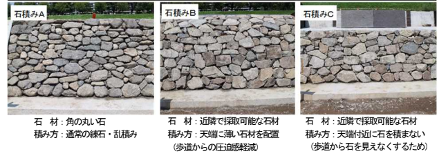
図7-7 試験施工結果(川側石積み)
