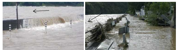
図1-3 パラペット越水状況 (平成30年7月豪雨)
