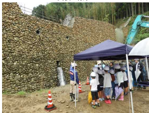
写真-4 砂防えん堤工事現場の現地見学の様子
