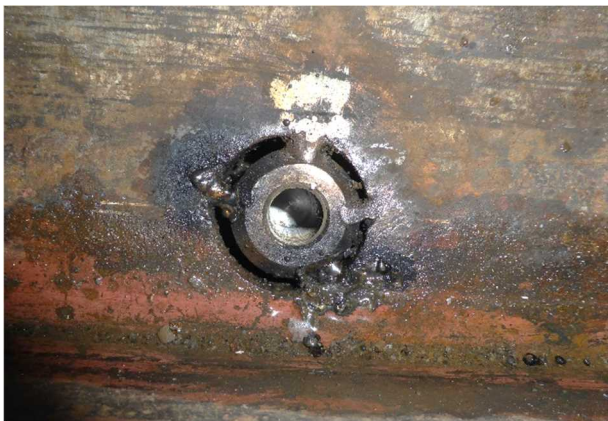
写真5 スリーブ仮溶接後の敷金物
