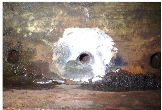
写真6 スリーブ本溶接後の敷金物
