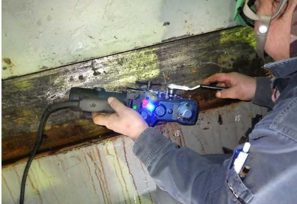
写真3 敷金物の穴あけ加工
