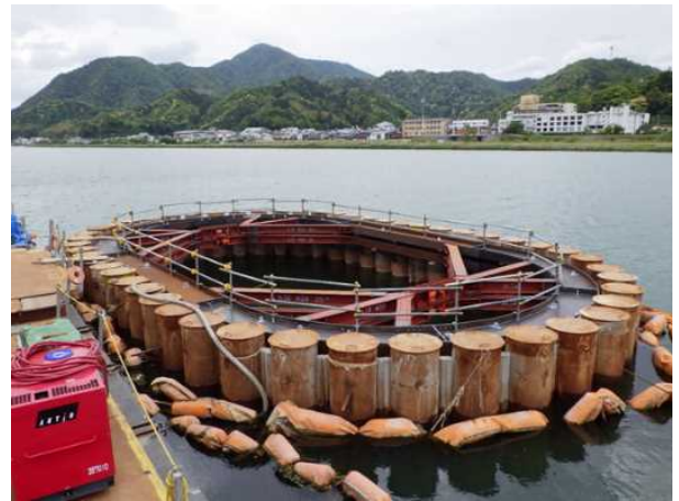
写真-1 仮締切り設置状況
