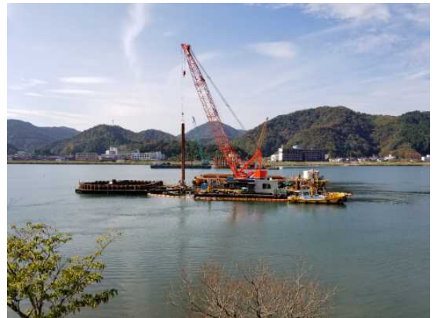
写真-2 台船施工状況
