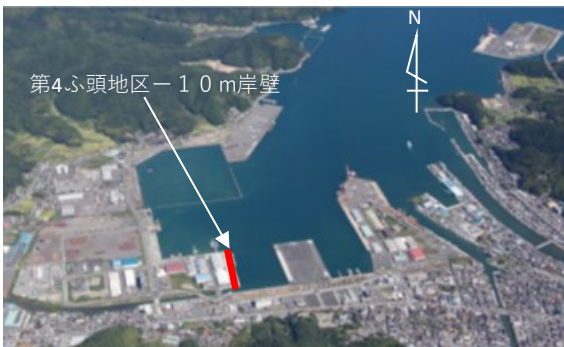
写真-1 舞鶴港第4ふ頭地区(航空写真)
