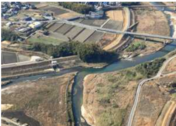
図一 4 木津川57.8k 付近 航空写真
