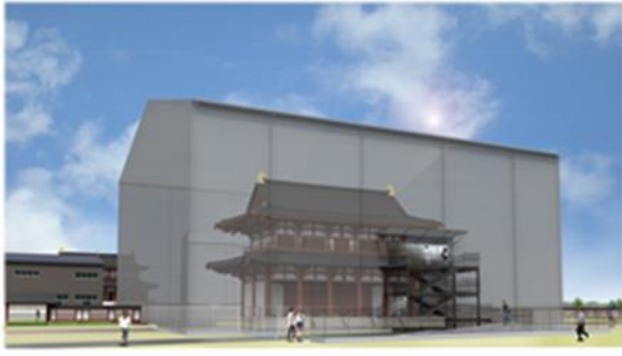
図-1-3 第一次大極殿院南門（素屋根）
