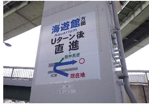
図-10 特定の誤進入形態をねらった対策例 (出路車両への注意喚起標示)
