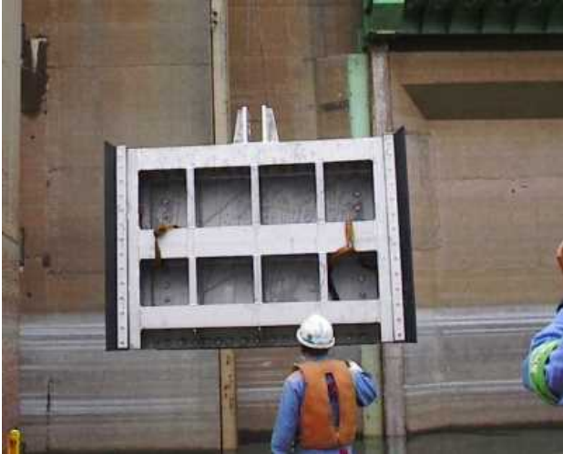
写真-1 補助取水ゲート更新状況
