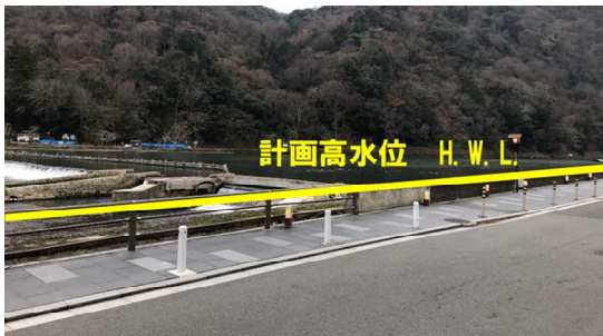
図-1 渡月橋上流左岸の状況
