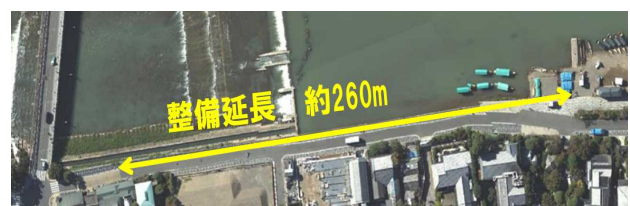
図-3 可動式止水壁整備区間
