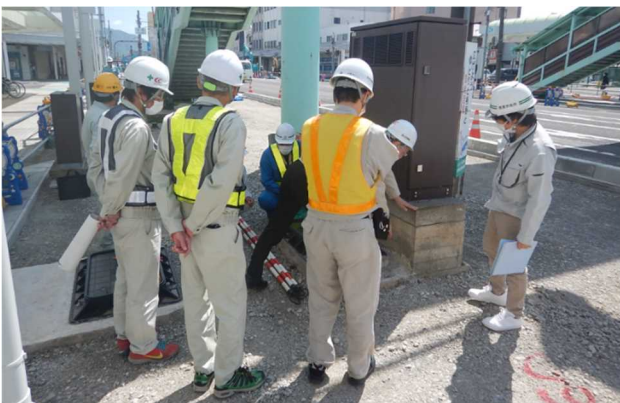
写真-11 現場確認の様子
