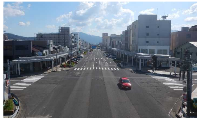
写真-1 本町通り（本町交差点から撮影）
