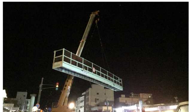
写真-10 歩道橋撤去
