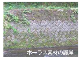
図-9 堤防天端の土系舗装とポーラス素材の護岸
