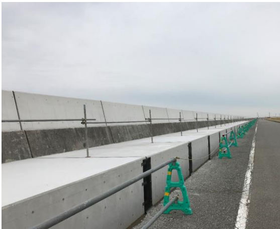
図-14 東側護岸嵩上げ現場
