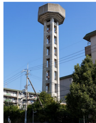
図2 平城団地給水塔
