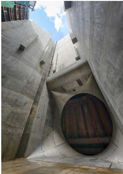
図-16 構築完了後の流入部（立抗内より）
