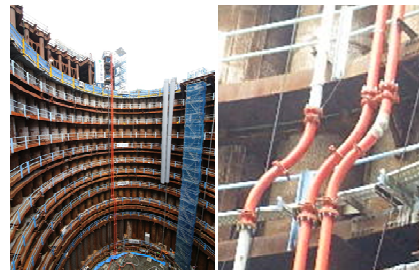
図-9 配管設置状況（左）とベンド管（右）
