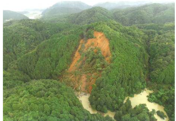
図-2 被災後の谷河川（2018年7月8日）
