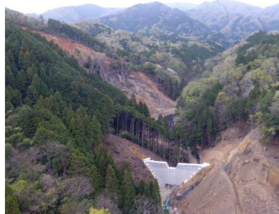
図-16 工事中の状況（2020年4月末撮影）
