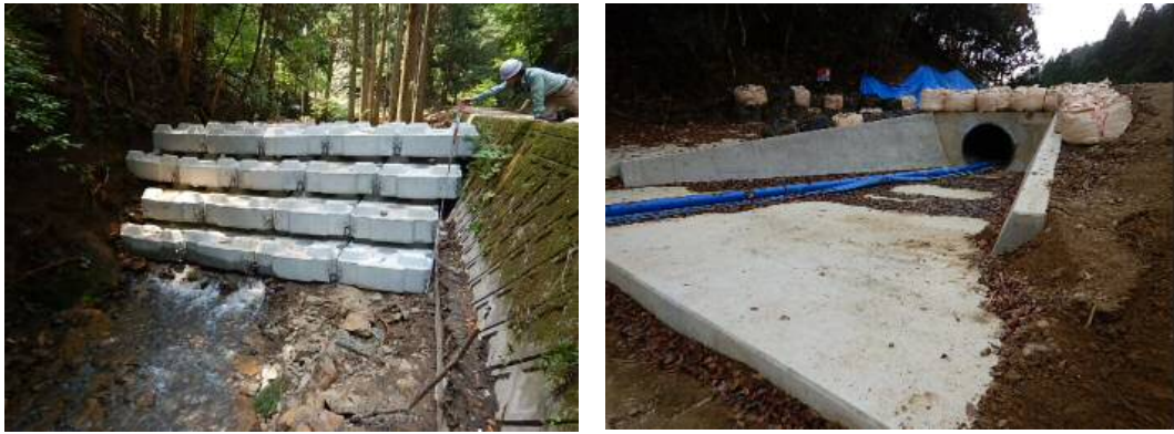
図-9 応急対策工事の状況
