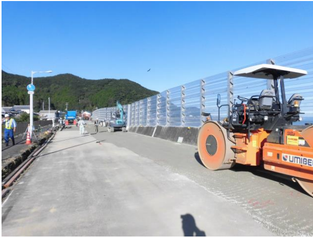
写真-3 第一次仮復旧写真その1
