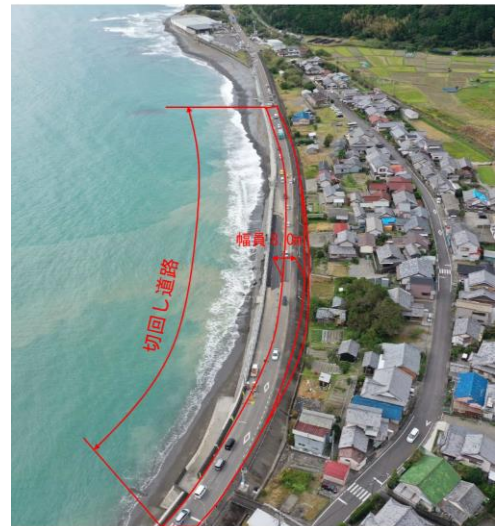
写真-6 ドローン空撮
