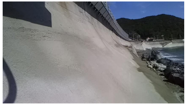
写真-5 防波堤空洞部のモルタル充填
