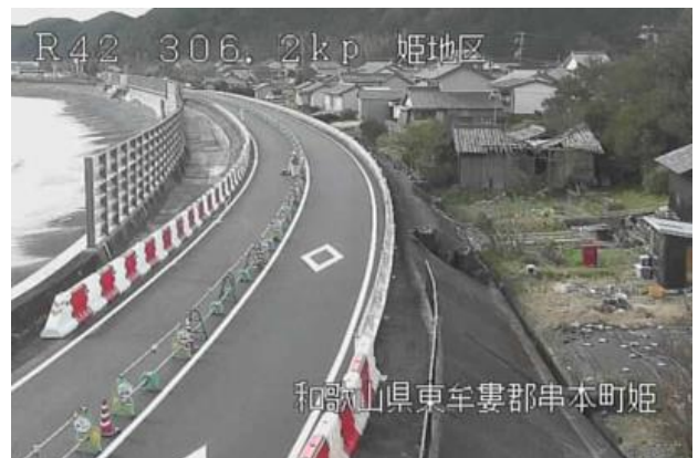
写真-7 第二次仮復旧完了写真
