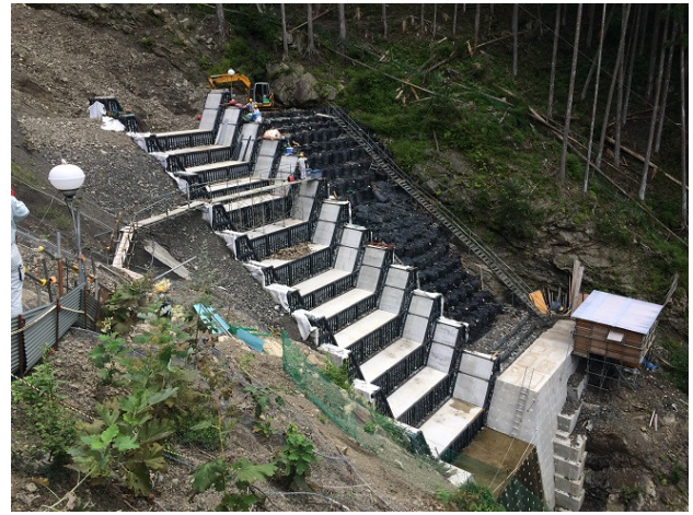
図-7 溪流保全工設置状況（遠景）
