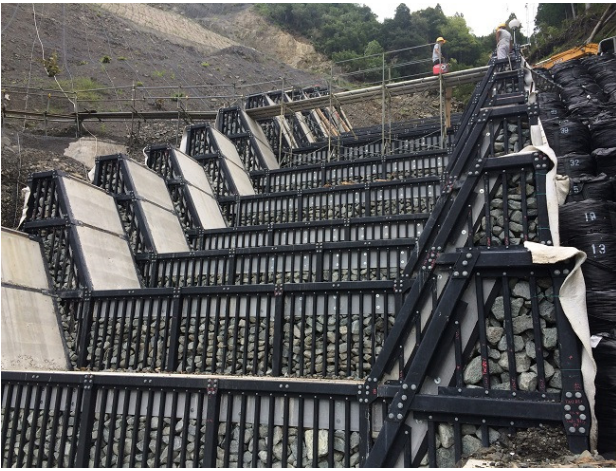
図-6 鋼製続枠設置状況
