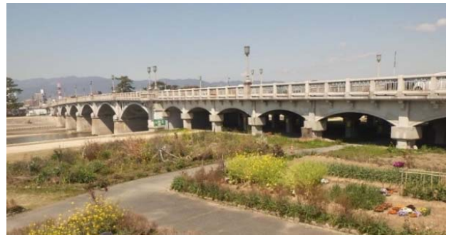
写真-15 工事完了後の武庫大橋
