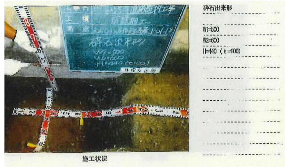
図-8 施工中写真 (一例)
