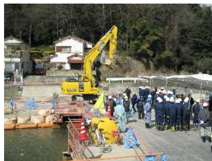
写真-1 工事の現場説明
