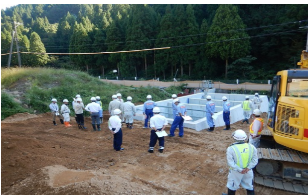
図-6 沈砂池視察状況
