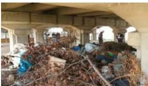
写真-13 撤去前状況
