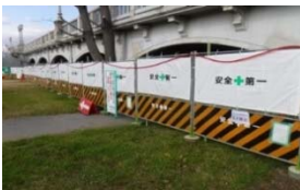
写真-11 仮囲い設置完了
