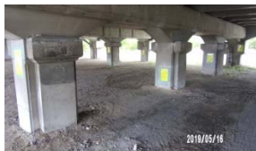
写真-14 撤去後状況
