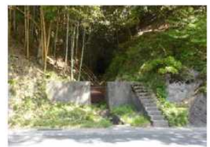
土砂流出対策工
