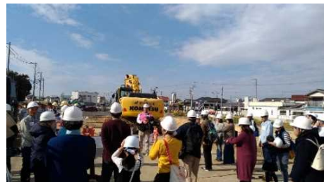
写真-7 別府川の工事現場見学の様子
