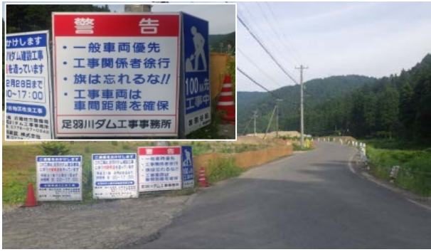
図-8 徐行看板等の設置状況
