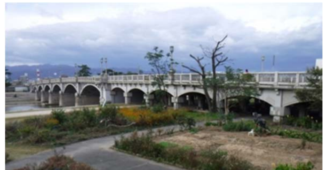
写真-1 武庫大橋（武庫川左岸（尼崎市）下流から）
