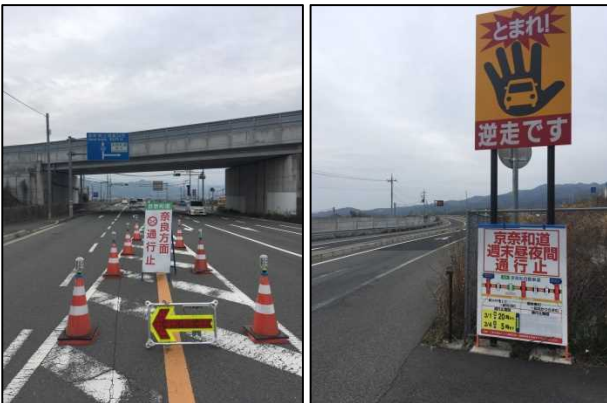
図-12 看板の設置状況
