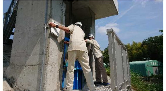
写真-3 点検実習
