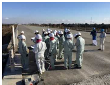
写真-4 インフラツアーの体験（供用開始前の東播磨道）
