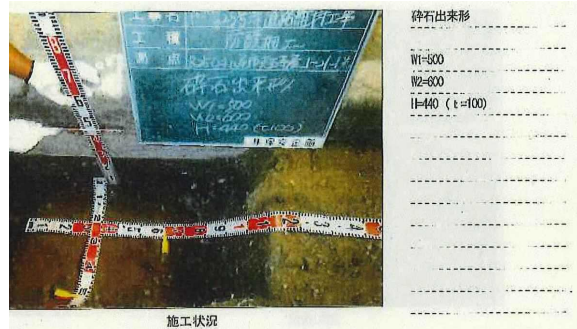
図-8 施工中写真 (一例)
