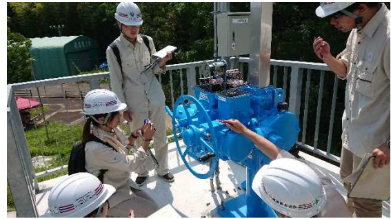
写真-2 操作実習
