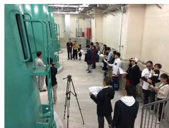
写真-8 曇川排水機場見学の様子
