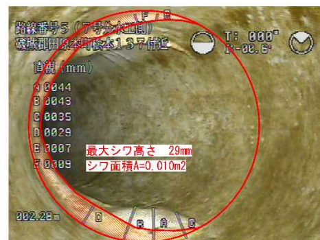
写真-1 管内カメラ映像の例
