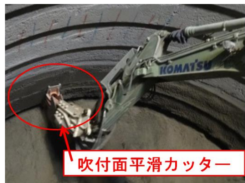
図-10. 吹付面平滑カッターと吹付面
