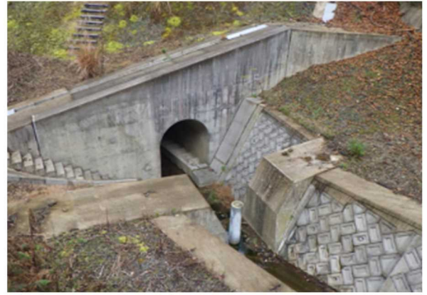
写真-3 アーチカルバート上流側状況
