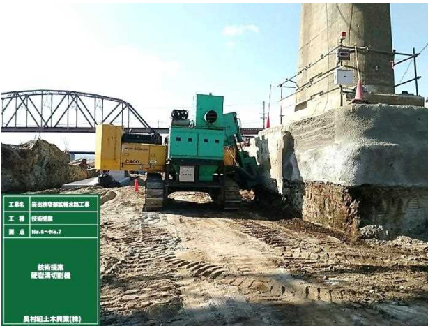
写真-3 硬岩溝切削機
