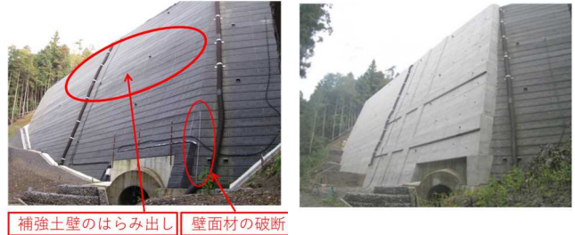
写真-4 追加補強工事前後
