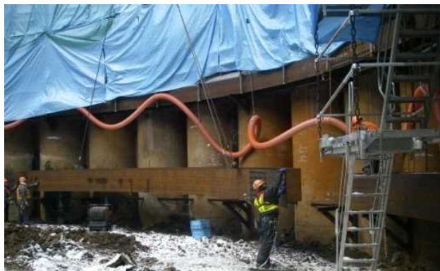
図-7 円環支保工設置の様子
