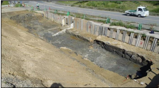
写真-2 擁壁の床堀状況と前面道路
