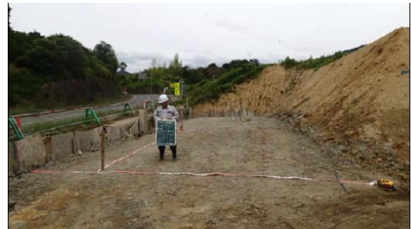
写真-5 地盤改良工の完了状況
