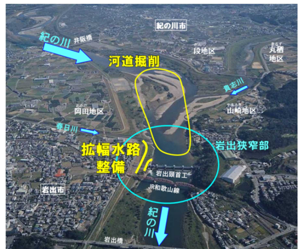
写真-1 岩出狭窄部
