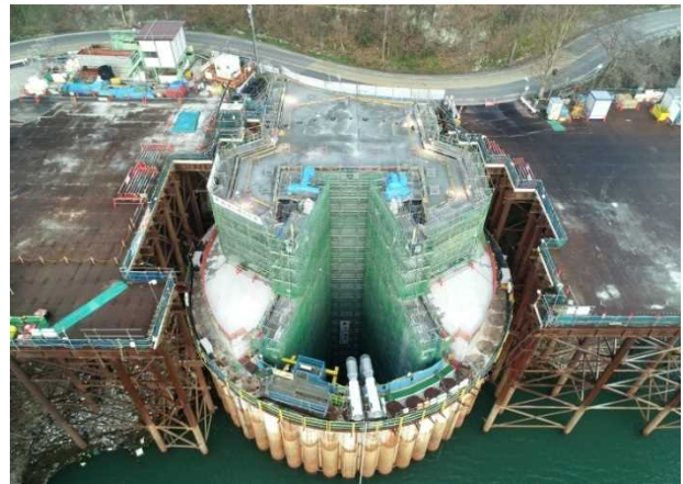
図-5 流入部の施工状況（平成31年3月）
