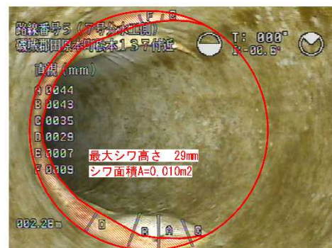
写真-1 管内カメラ映像の例
