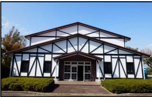
図-1 寄宿舎併設施設（体育館）外観
