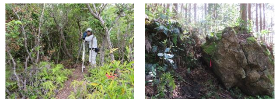
図-8 点検箇所(左)No.234+40付近、(右)No.307+80付近
