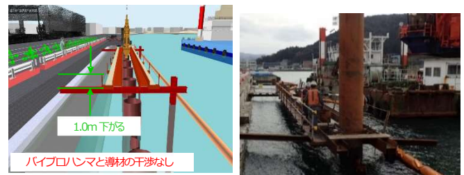
図-8 対策及び現場での施工状況
