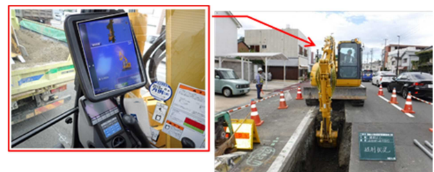
図-7 ICTバックホウによる掘削状況
