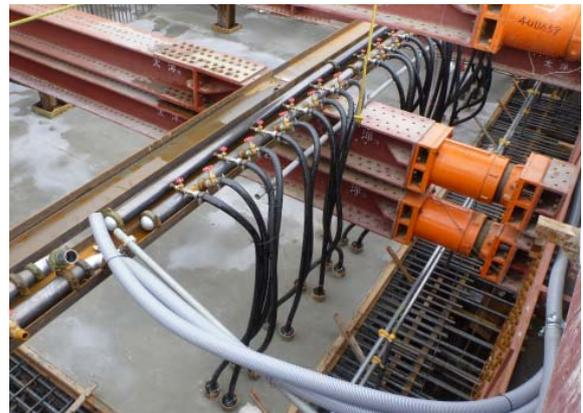
図-5.クーリングパイプ配管状況
