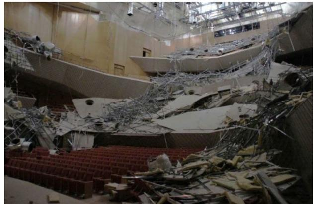
図1 東北地方太平洋地震時の音楽ホール被害<sup>1)</sup>
