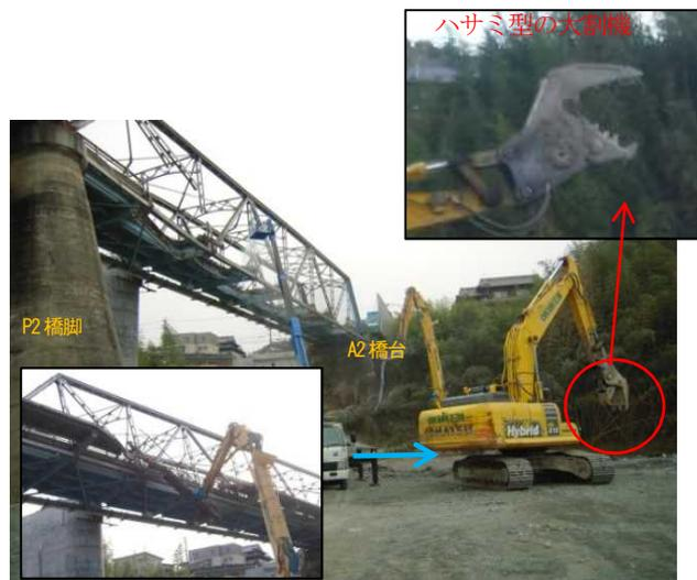
写真7 橋桁撤去作業
