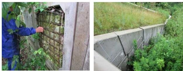
図5 補強土壁の変状（左：損傷 右：開き）
