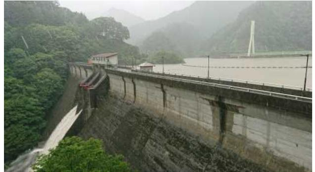
写真-1 異常洪水時防災操作状況
