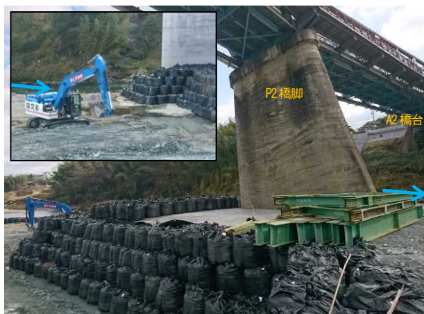
写真6 橋脚固定作業
