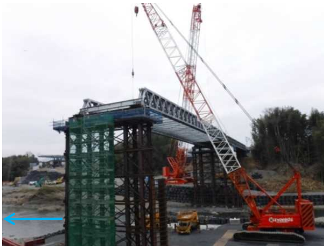
写真9 架設状況②
