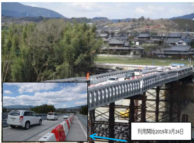
写真10 仮設橋の利用開始
