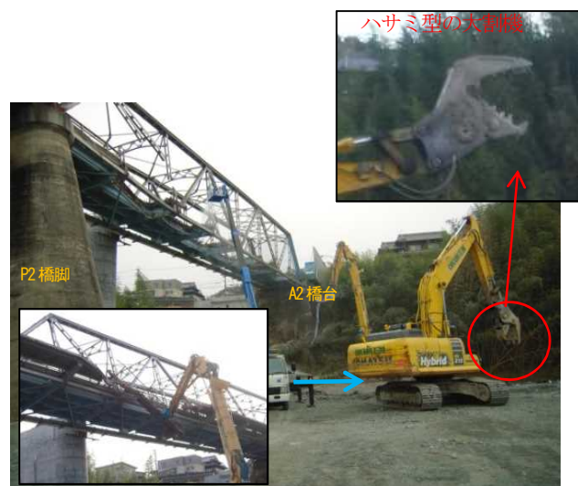
写真7 橋桁撤去作業
