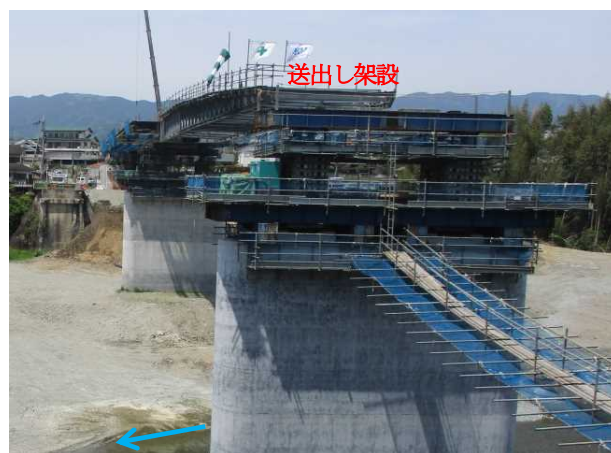
写真1 新しい恋野橋の架設状況（2019年4月末状況）
