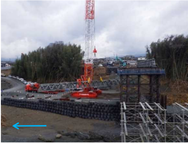
写真8 架設状況①
