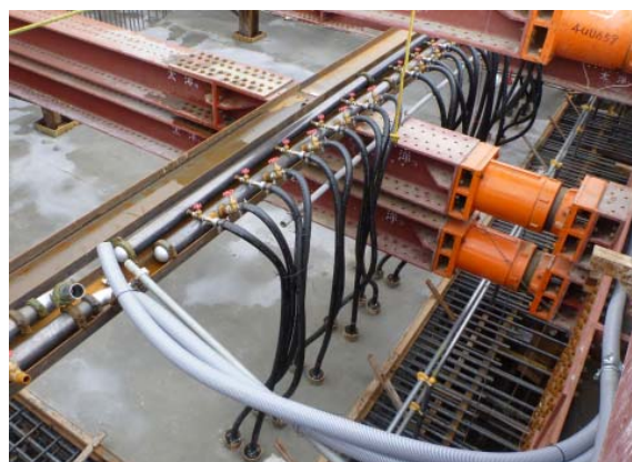
図-5.クーリングパイプ配管状況
