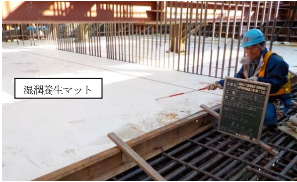
図7.湿潤養生マット設置状況
