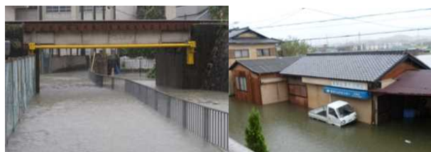
写真-2 木津川市内水被害写真(平成25年台風18号)
