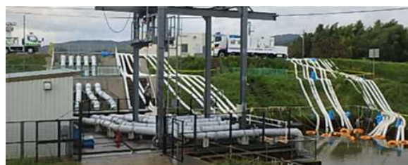
写真-3 木津合同樋門排水状況(平成29年台風21号)
