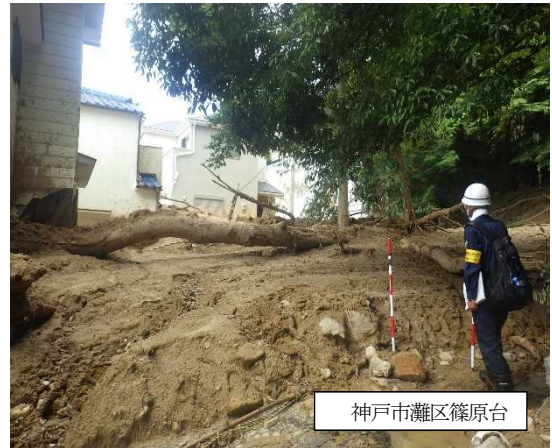
図－6 谷出口付近の土砂堆積状況
