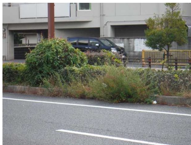
写真-1 国道42号中央分離帯 (対策前)
