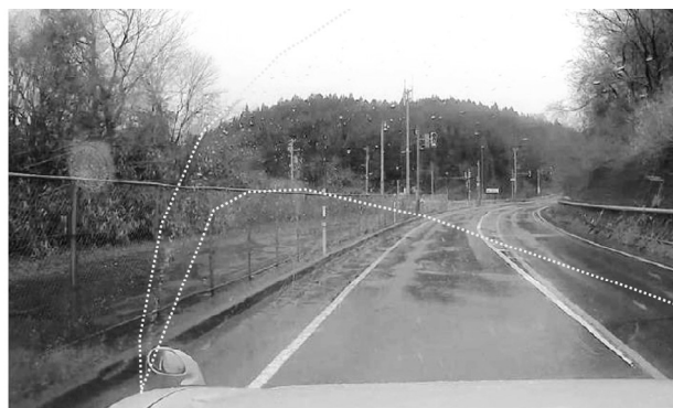
図-3 散水管の不具合(破線内)
