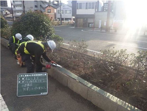
写真-5 防草シート施工
