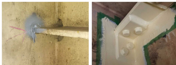
写真5 あて板補強工
