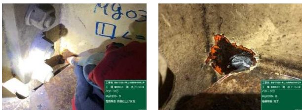
写真4 削り込み工
