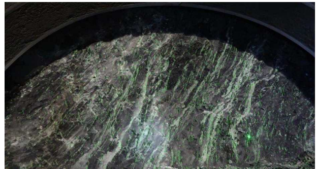
写真-2：割れ目認識状況
