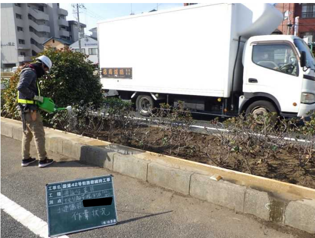
写真-7 散水状況
