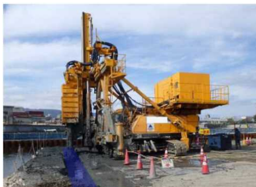
写真-2 粘性土系遮水壁の施工状況
