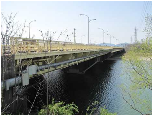
写真-1 橋梁全景
