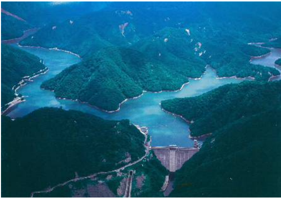
写真-1 笹生川ダム全景
