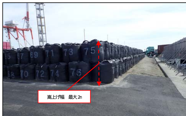
写真-9 大型土のう設置状況
