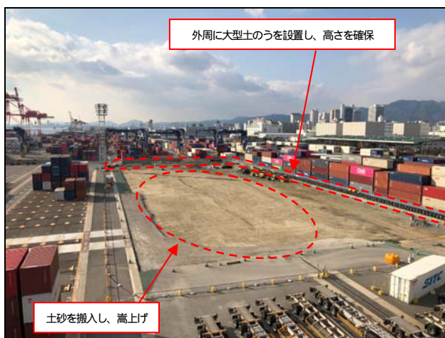
写真-8 ターミナル内の嵩上げ状況 (stage4-2工区)
