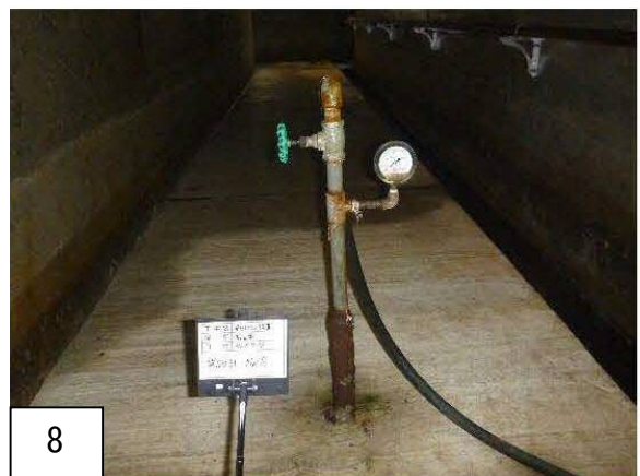
写真-2 ブルドン管外観 (No. 8)
