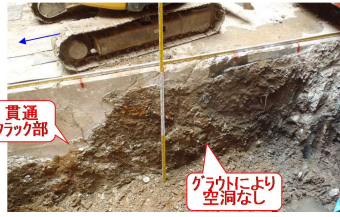
図-22 杭頭部の状況
