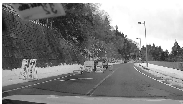
図-2 施工業者による交通規制の実施状況
