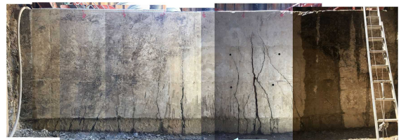
図-20 函渠外側の状況
