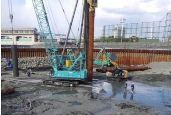
写真-1 鋼管基礎杭の施工(湧水噴出)
