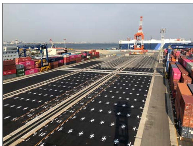
写真-10 工事完成時 (stage4-2工区)
