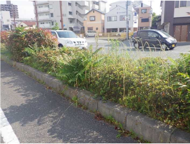
写真-10 未対策箇所
