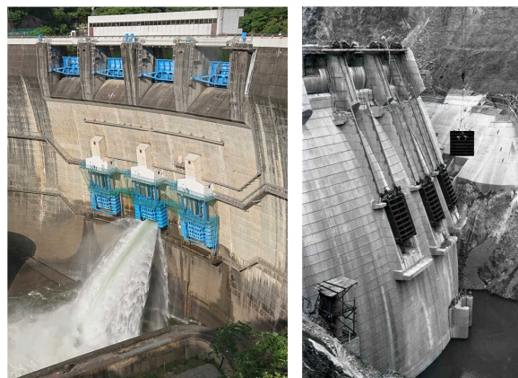
図-1 天ヶ瀬ダムゲート設備（左：下流側 右：上流側）
