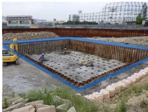
写真-3 遮水対策後の掘削状況
