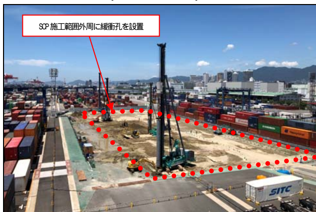
写真-7 緩衝孔の施工状況
