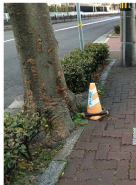
写真2 根の生長が抑制され、縁石を破壊（ケヤキ）
