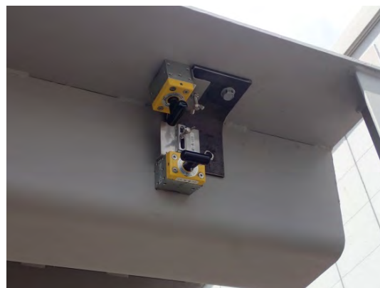
写真-6 (TRSを用いた当て板補修の練習)
