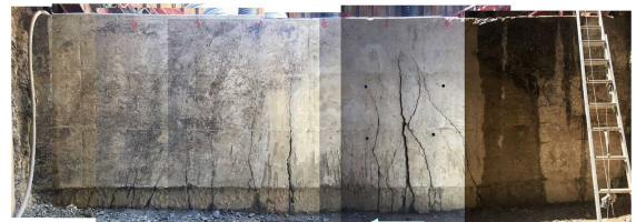
図-20 函渠外側の状況
