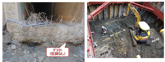
図-21 函渠周辺の状況
