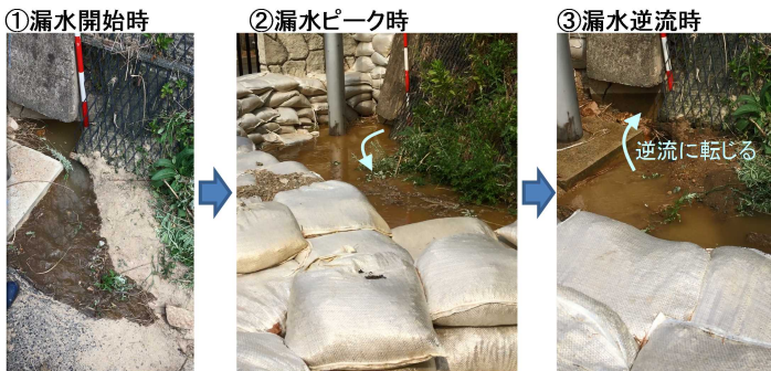
図-14 漏水の様子
