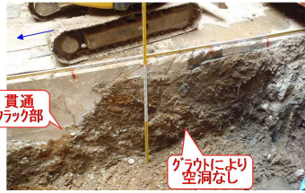
図-22 杭頭部の状況
