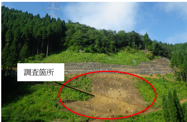
図-9-1 調査箇所の状況 (2015年8月)
