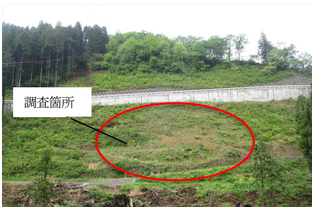
図-9-2 調査箇所の状況 (2018年5月)
