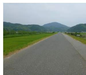
図10. 台風前の堤防
