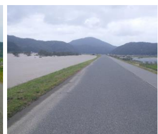
図11. 台風後の堤防
