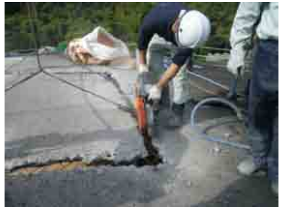
写真9 RCドーム屋根とりこわし工
