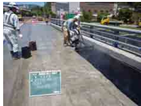
写真12 舗装接着材塗布状況
