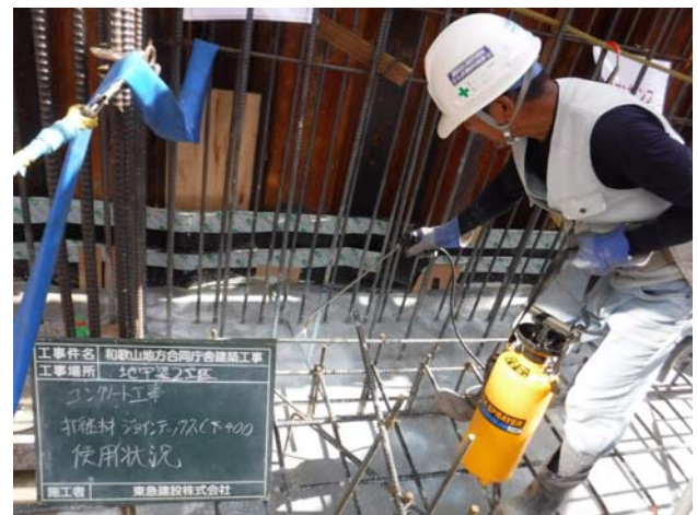
写真-3 水平打ち継ぎの止水対策
