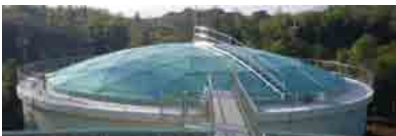
写真 21 屋根の設置・架橋完了
