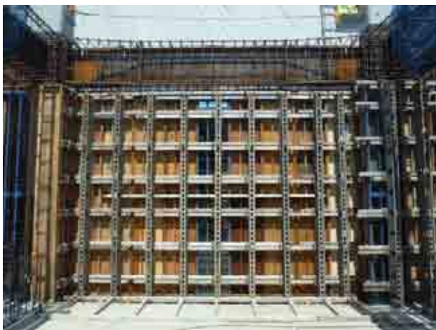
写真-5 透明型枠
