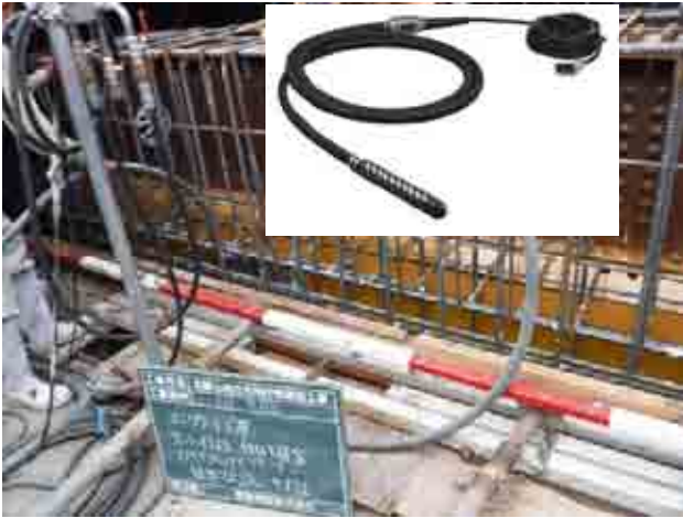
写真-7 スパイラルバイブレータ
