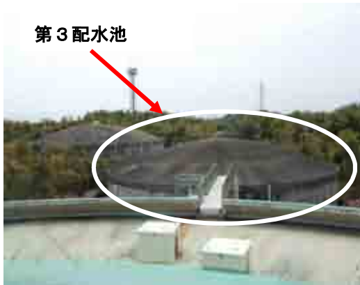
写真3 第3配水池屋根(施工前)
