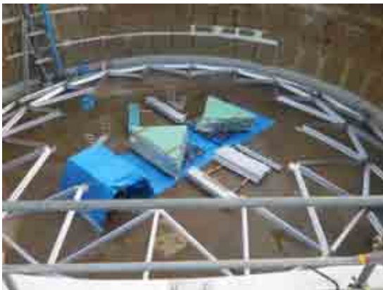
写真 13 フレーム組立て
