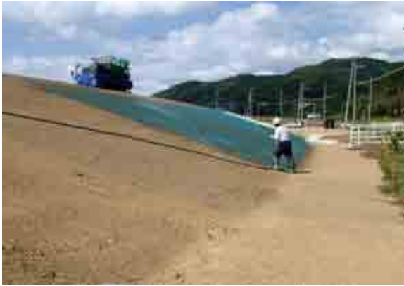
図-9 改良ムカデシバの種子吹付状況
