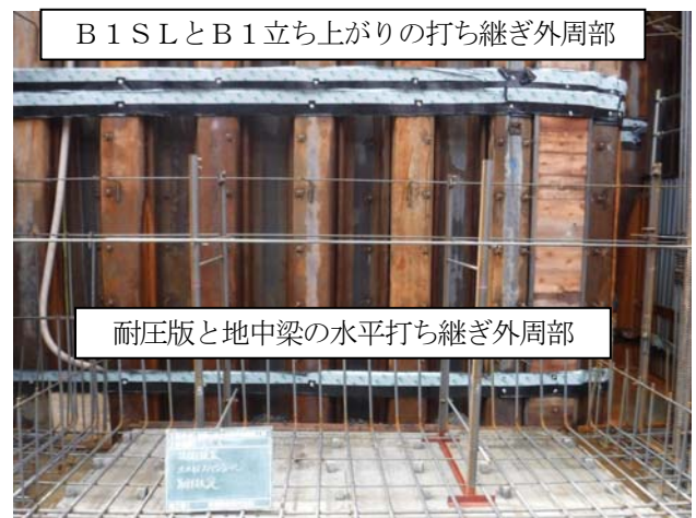
写真-2 水平打ち継ぎの止水対策
