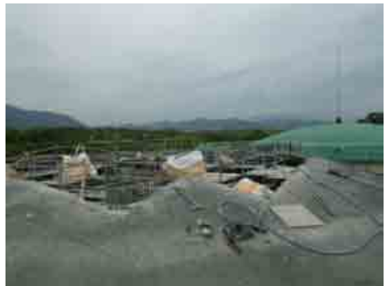
写真10 RCドーム屋根撤去工
