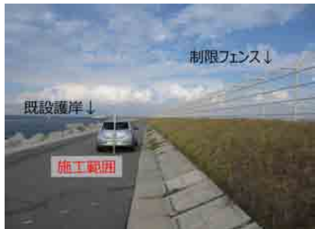
写真-1 2期島A3護岸施工前風景
