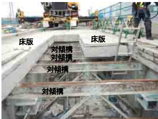
写真-2 対傾構の上に床版が載荷している
