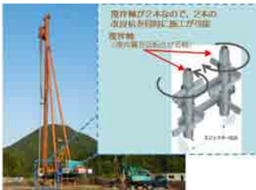
図-8 深層混合処理工の一例
