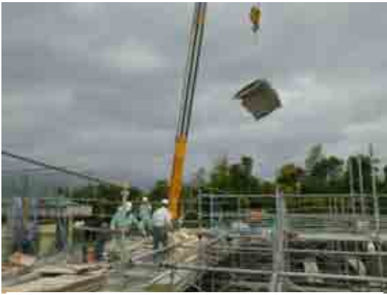
写真 11 クレーン吊下ろし状況
