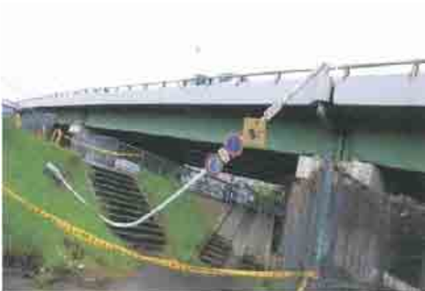
写真-1 石切跨道橋
