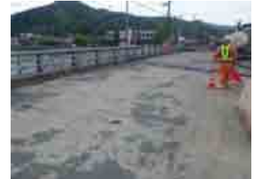
写真4 AS切削後の床版表面
