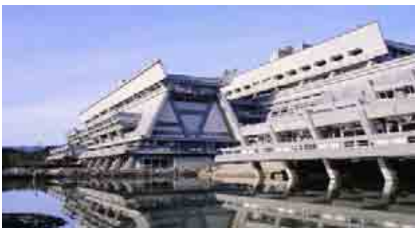
写真-1 国立京都国際会館本館全景
