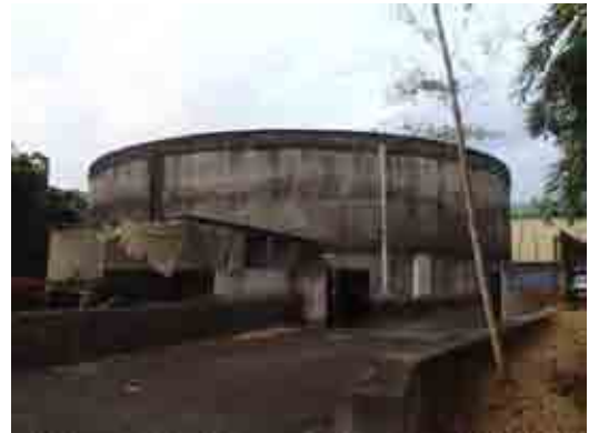
写真1 第3配水池全景(施工前)
