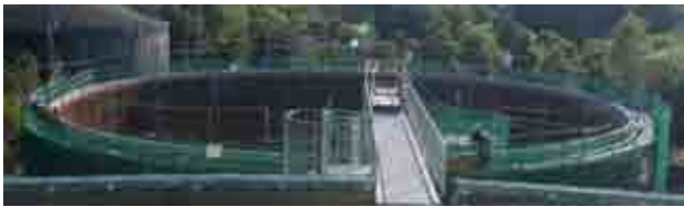
写真 12 RCドーム屋根撤去完了
