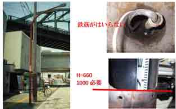
写真-4 施工困難事例
