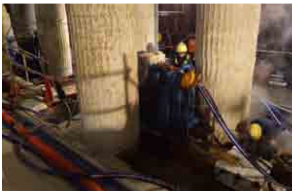
写真-15 狭隘部施工状況
