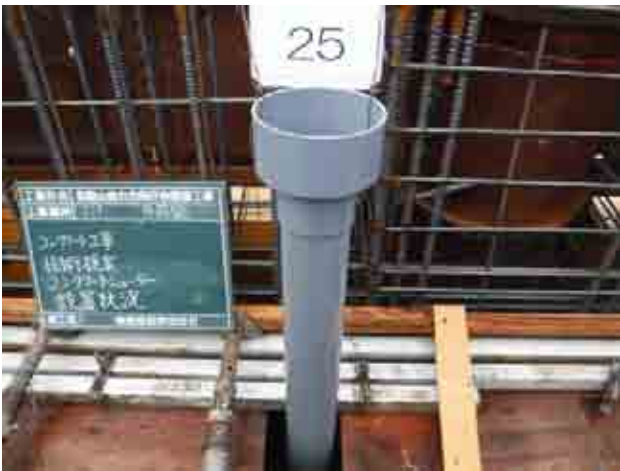
写真-8 コンクリートシューター
