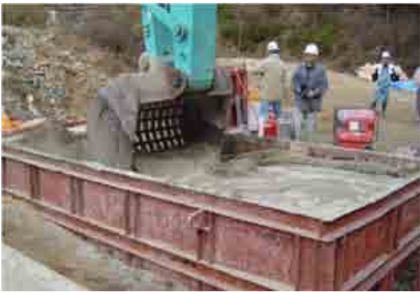
写真 INSEM-Fタイプの施工状況
