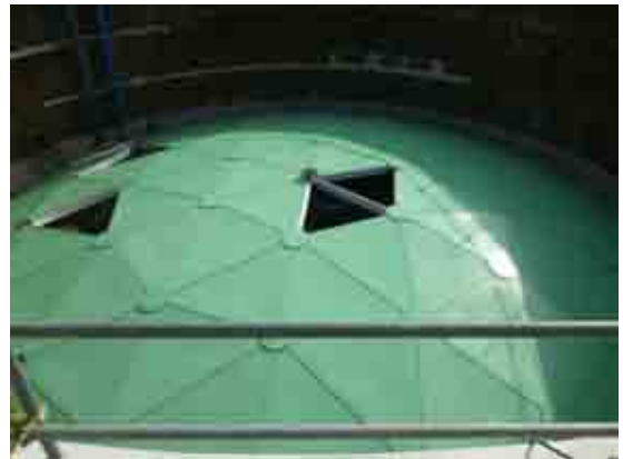
写真 16 パネル取付完了
