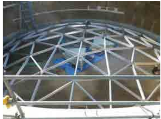
写真 14 フレーム組立完了
