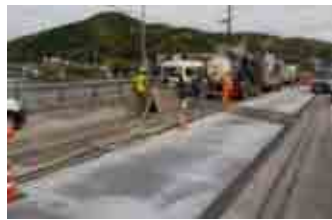
写真11 特殊コンクリート打設完了状況
