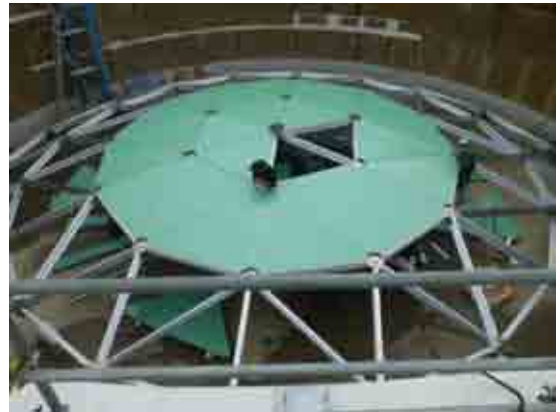
写真 15 パネル取付け
