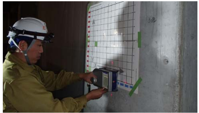
写真-10 柱のRCレーダーによる3Dスキャンの状況
