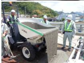
写真7～10 特殊コンクリートの製造及び打設状況
