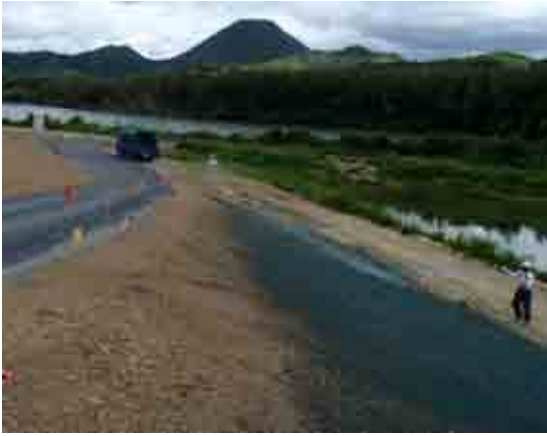
図-5 ノシバ種子吹付の施工状況
