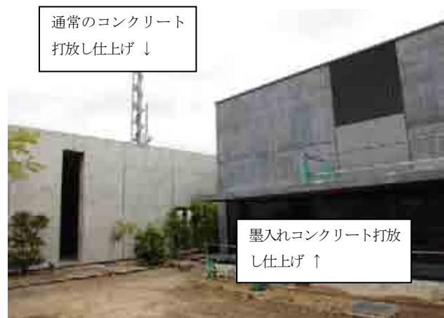
写真-5 墨入れコンクリート仕上がり状況
