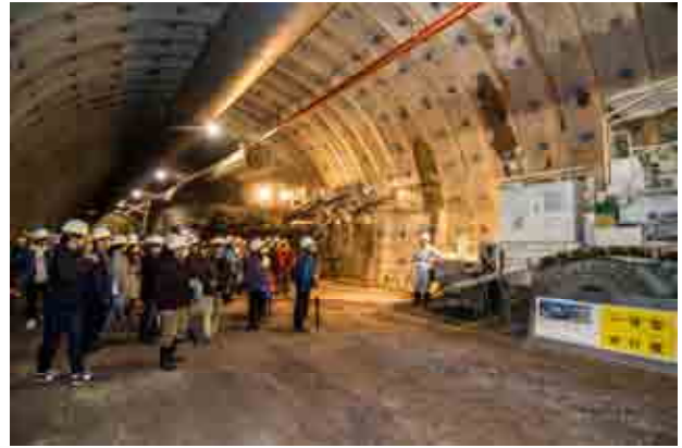
柵布トンネル会場では、施工業者がDVDを使用しNATMトンネルの施工方法等の説明を実施した。
