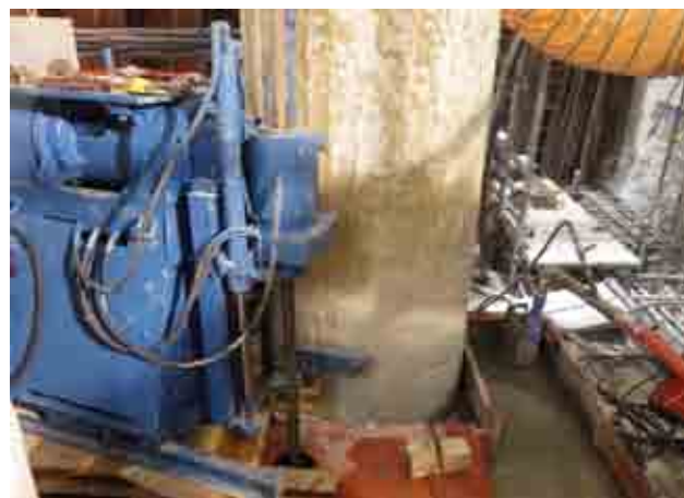
写真-12 排泥クローズドシステム
