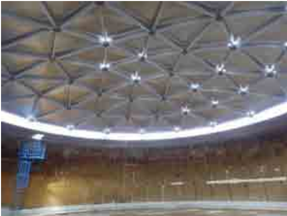
写真 20 配水池内部の状況
