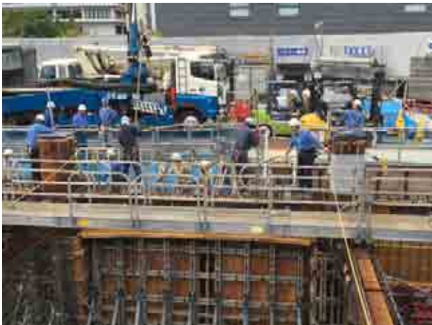
写真-9 打設状況
