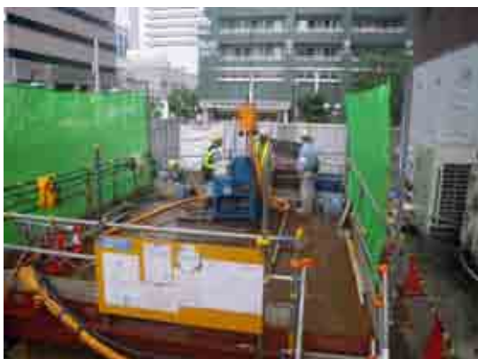
写真-8 試験施工実施状況
