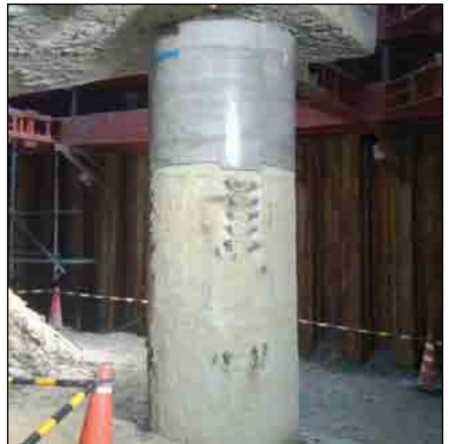
写真-4 杭基礎仮補強
