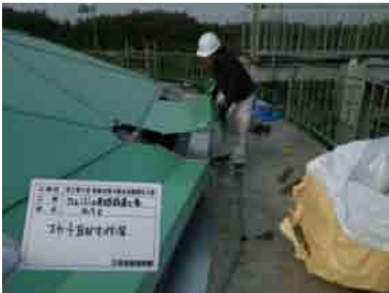
写真 19 スカート取付け
