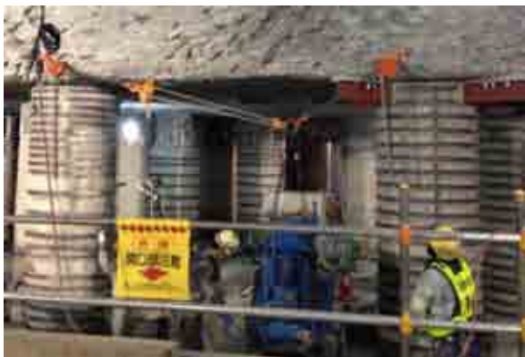
写真-14 施工機移動状況
