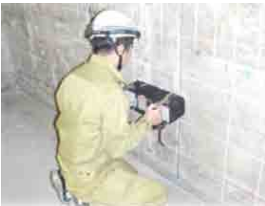
写真-12 超音波探査の状況
