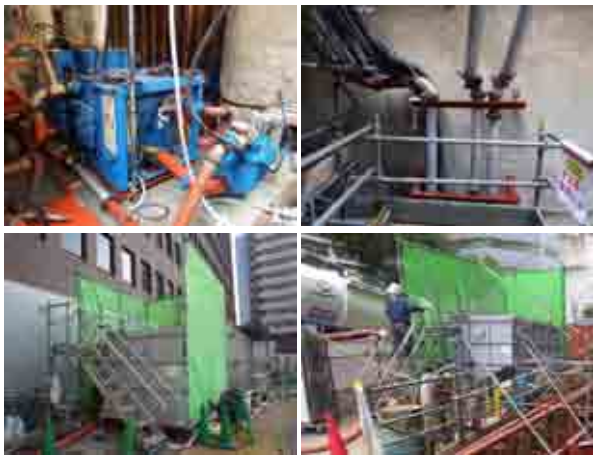
写真-13 排泥処理状況
