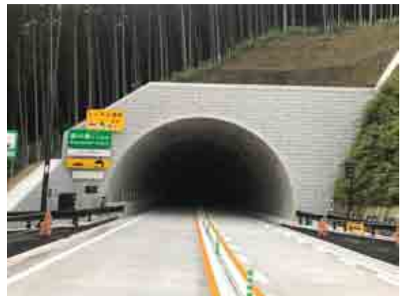
写真-1 風の森トンネル（終点側）
