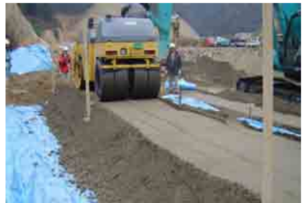
写真 INSEM-Cタイプの施工状況
