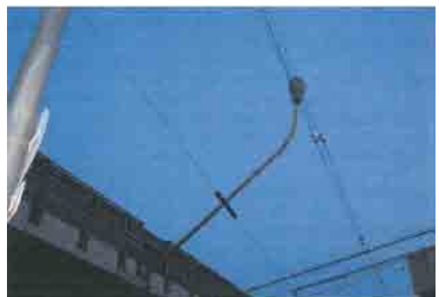
写真-2 志岐跨線橋
