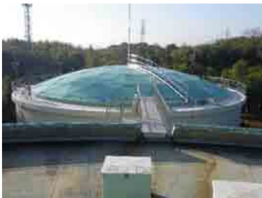
写真4 第3配水池屋根(施工後)
