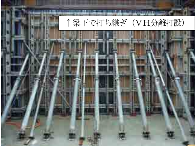
写真-4 セパレータを用いない型枠工法
