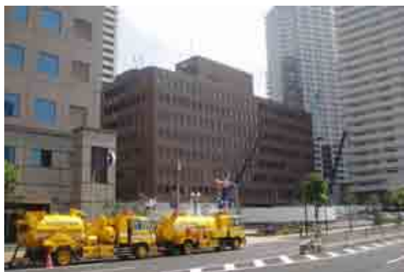
写真-1 神戸地方合同庁舎 工事状況
