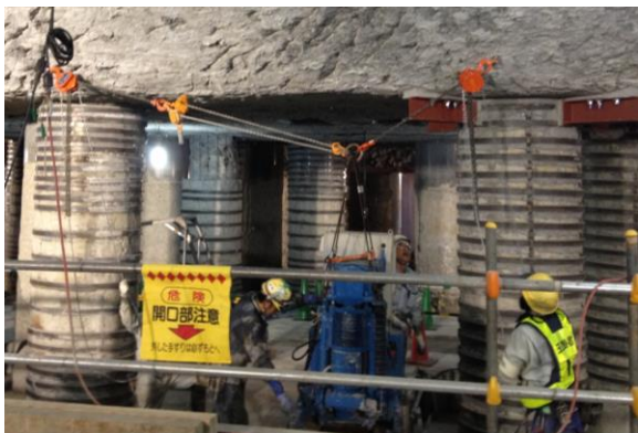
写真-14 施工機移動状況
