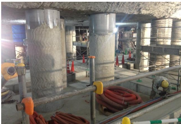
写真-5 地下空間内 状況写真
