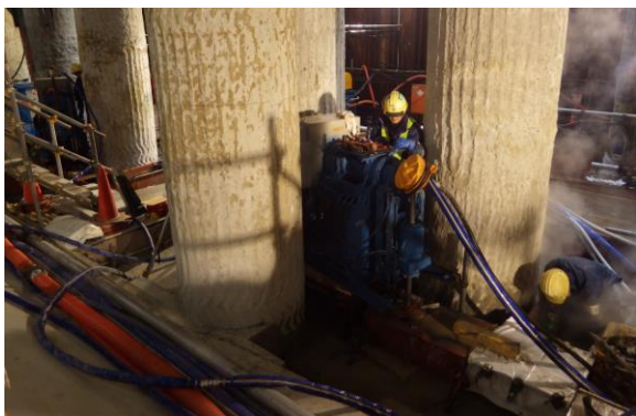
写真-15 狭隘部施工状況
