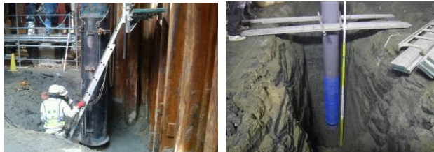
写真-16 ディープウェル対策状況
