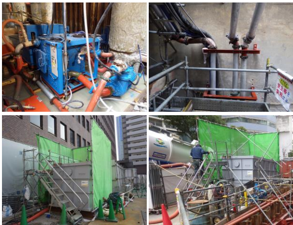
写真-13 排泥処理状況
