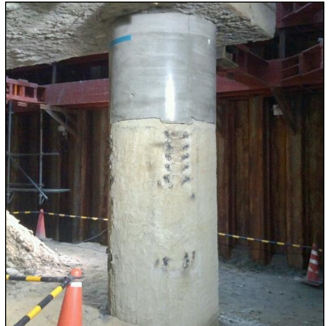
写真-4 杭基礎仮補強
