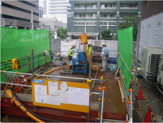
写真-8 試験施工実施状況
