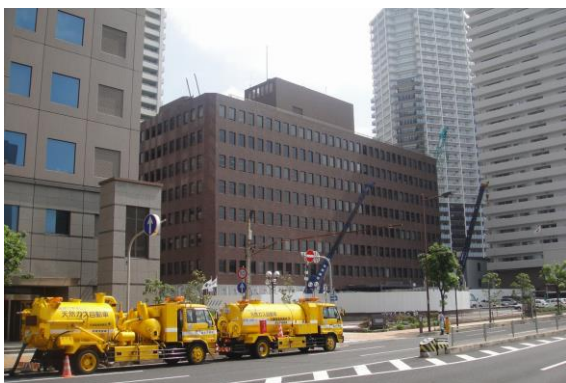
写真-1 神戸地方合同庁舎 工事状況
