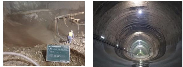
写真-6,7 仮インバート吹付状況及び施工完了写真
