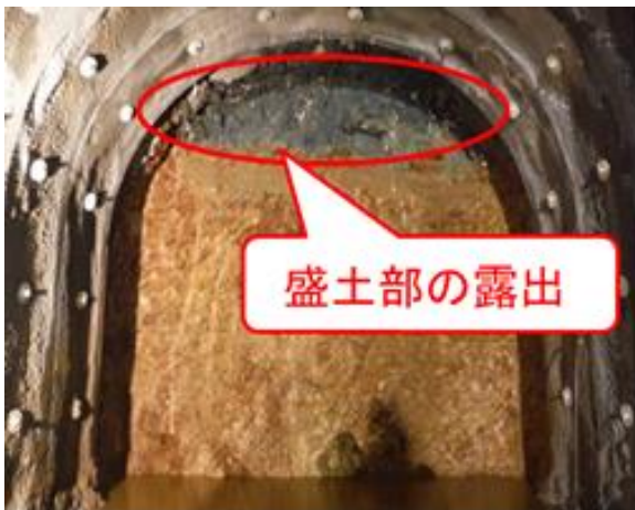
写真-4 先進導坑内盛土露出状況
