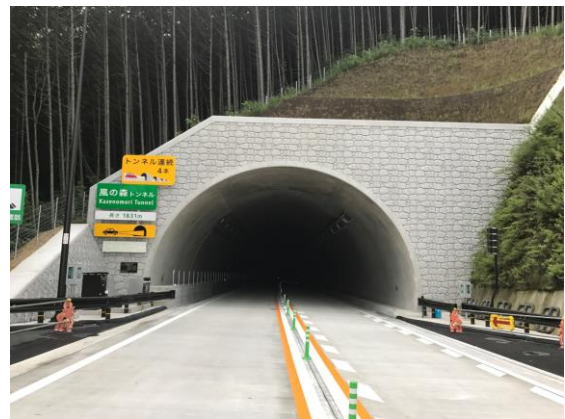
写真-1 風の森トンネル（終点側）
