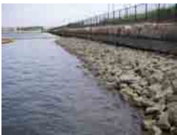
写真-4 捨石緩傾斜型護岸の様子
