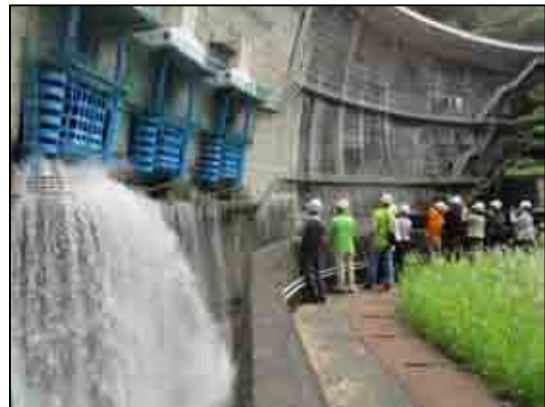
写真-2 コンジットゲート点検放流
