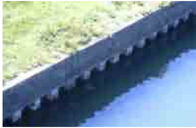
図-4 野洲川河口部の矢板護岸構造
