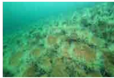
写真-5 緩傾斜型護岸の様子(水中)
