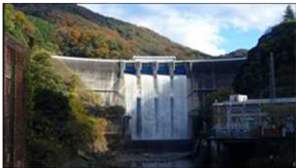
写真-3 クレスト点検放流（撮影場所：白虹橋）
