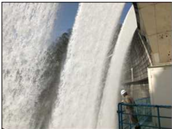
写真-5 クレスト点検放流（撮影場所：キャットウォーク）（2）
