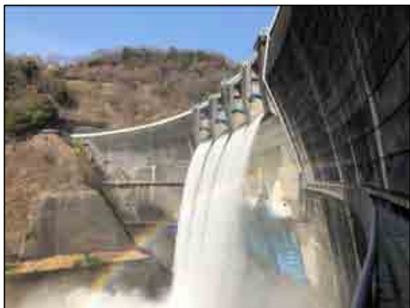
写真-4 クレスト点検放流（撮影場所：キャットウォーク）（1）
